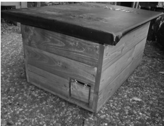
Das Dach wird mit dicker Teichfolie bezogen, da Dachpappe leicht reißt. Der Dachüberstand sollte auf allen Seiten mindestens 7 cm betragen. Zum Erhalt des Holzes wird das Haus **nur außen** mit einem pflanzenfreundlichen Holzschutzmittel gestrichen. Der Vorraum wird täglich mit Zeitungspapier ausgelegt, weil die Igel beim Fressen gerne Schmutz machen. Er wird, wenn verschmutzt, täglich gereinigt und mit neuem Papier ausgelegt. Setzt man einen Karton in den Schlafraum, eignet sich am besten
